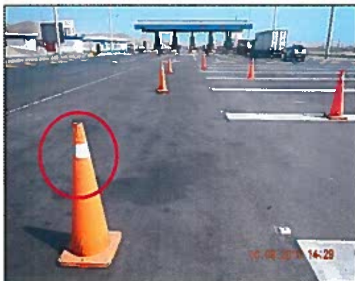
CONOS DE LA UNIDA DE PEAJE SU HUARMEY CON UNA SOLA CINTA REFLECTIVA
