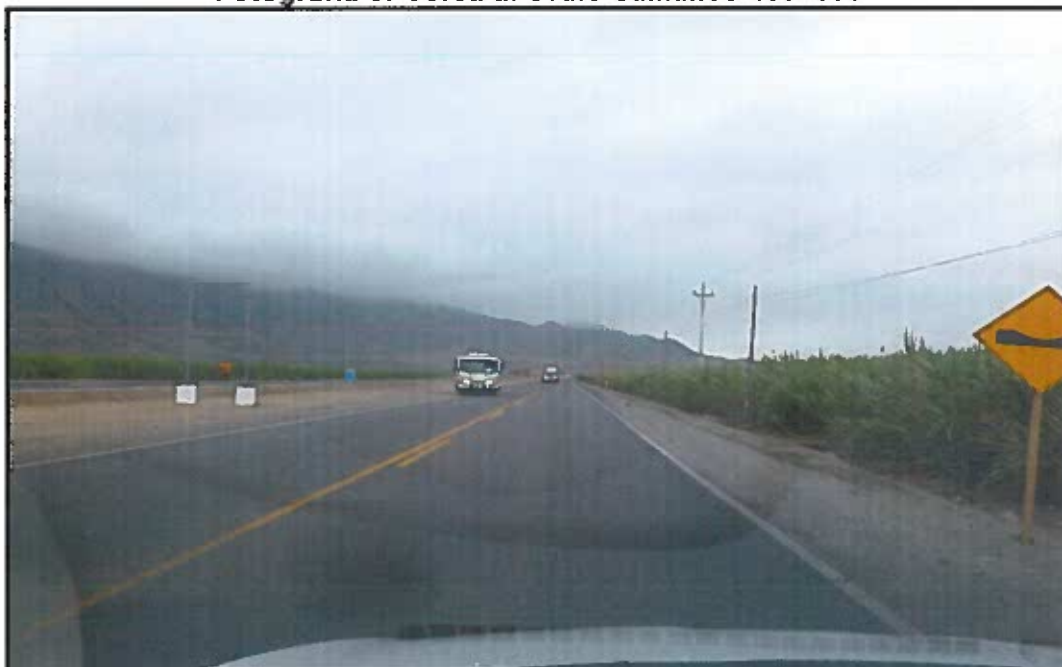
Fotografía 6: Cerca al óvalo Samanco 408+500
