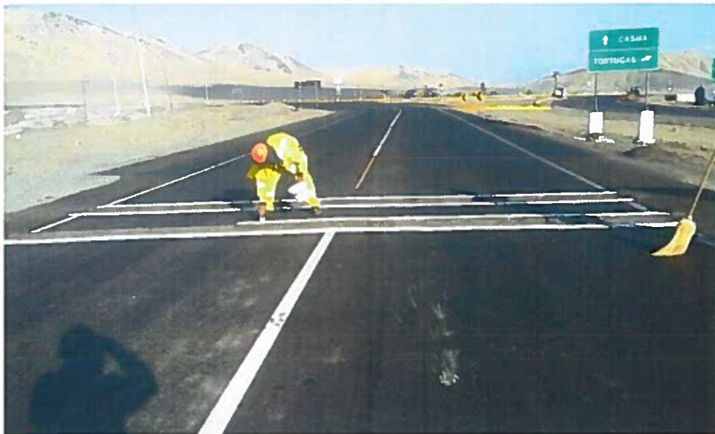
Fotografía 4: Construcción de Bandas de fresado Acceso Norte Ovalo Tortugas
