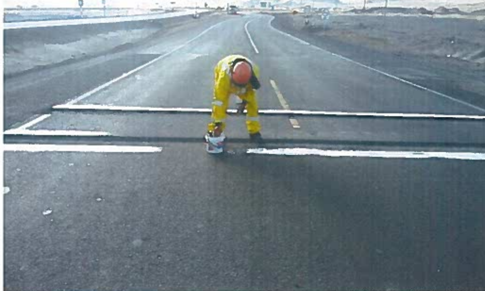
Fotografía 5: Construcción de Bandas de fresado Acceso Sur- Ovalo Tortugas
