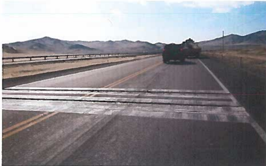
Fotografía 2: Bandas de fresado en operación
