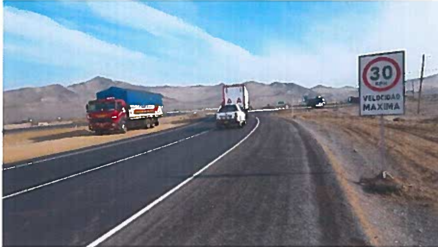
Fotografía 1: Señal Reglamentaria Vmax= 30KPH
