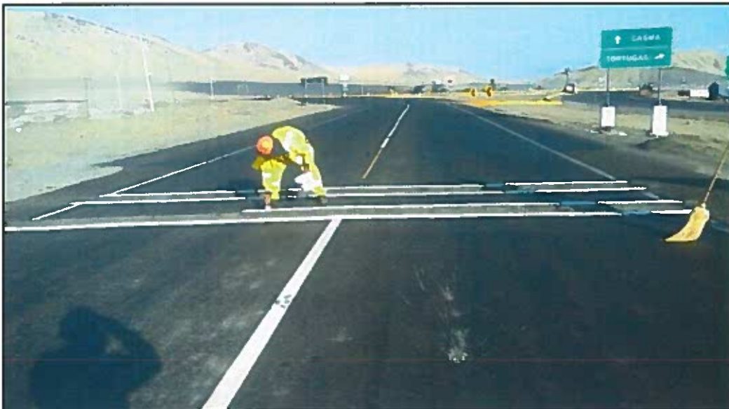
Fotografía 4: Construcción de Bandas de fresado Acceso Norte Ovalo Tortugas
