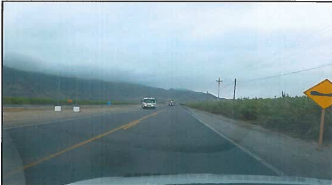
Fotografía 6: Cerca al óvalo Samanco 408+500
